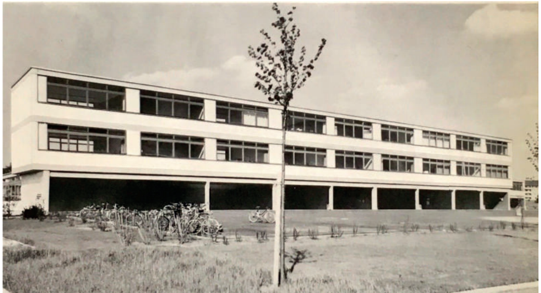
Der Neubau der Adolf-Reichwein-Schule
